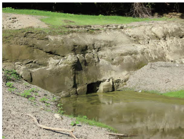
写真2.現れた上池と下池を結ぶ隧道
