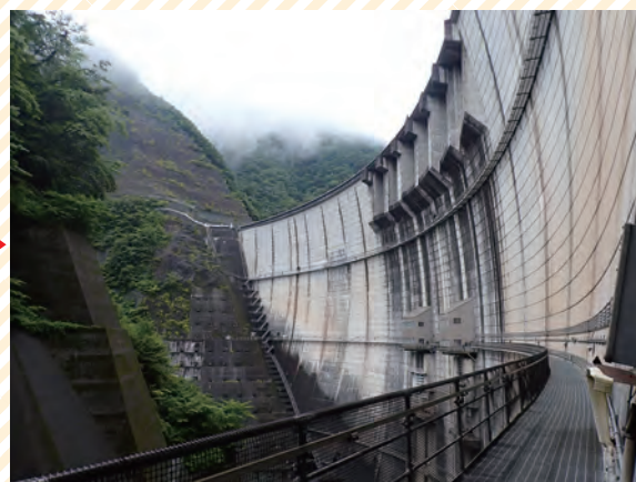
点検通路からの写真
