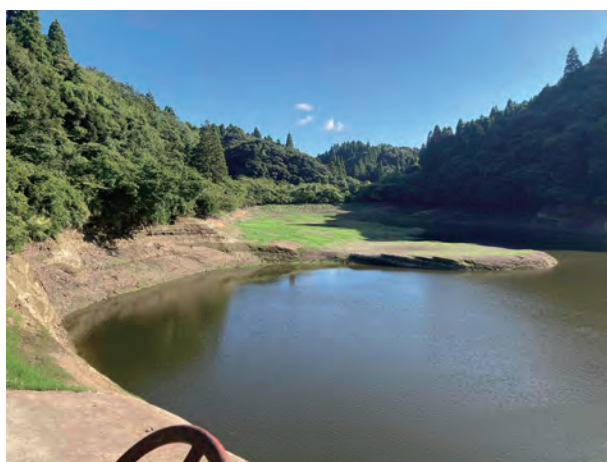
写真1.水位が大きく低下した大欠池の下池
