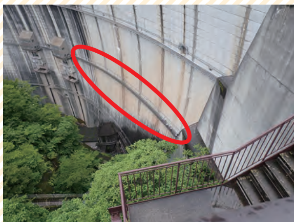
点検通路歩行中
